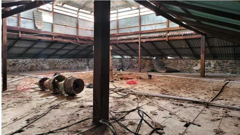
Gambar 1. Kondisi di atas plafon masjid
