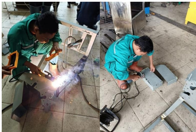
Gambar 3. Proses pengelasan bagian mesin pencacah
