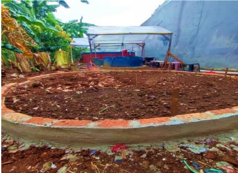
Gambar 3. Proses Pembuatan Alas Kolam
