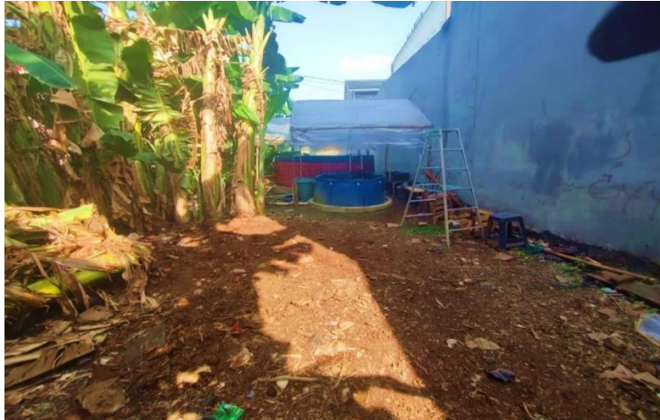
Gambar 2. Pembersihan dan pemerataan lokasi
