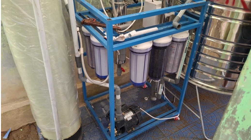
Gambar 4. Kegiatan penerapan teknologi menghasilkan terpasangnya satu unit Smart Filtration Backwash System
